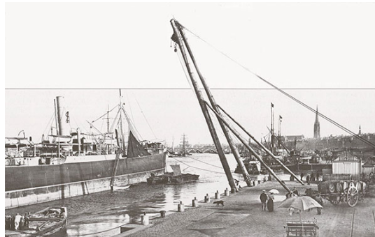
Le quai de la Mâtire au début du siècle. La machine à mâter, identique à celle du Havre, a été installée en 1853. Un charbonnier vient de relâcher ses amarres pour libérer l'accès au quai. Remarquer la présence de la ligne de chemin de fer qui permet aux wagons de venir à proximité des navires. © Roger-Viollet
